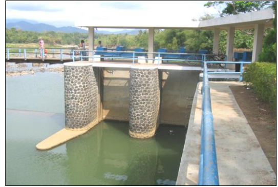
Intake Bendung Boro
