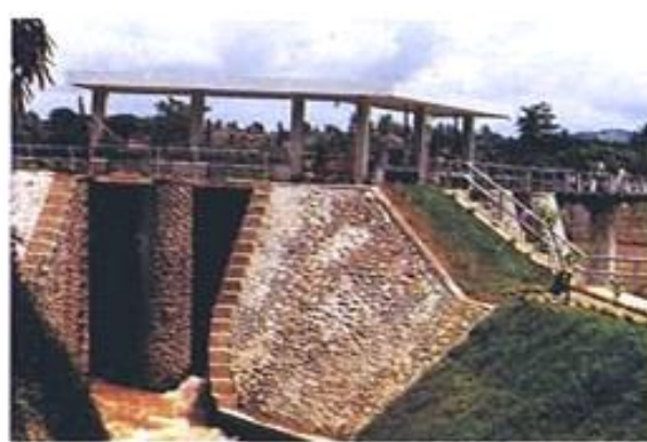
PINTU PENGAMBILAN BENDUNG BORO
