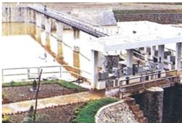
Bendung Boro Tampak Hulu
